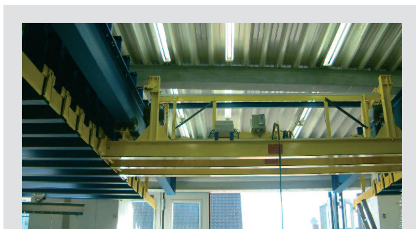
▲ Der Querverschub der Warenträger erfolgt, ähnlich einem Kran, mit einem elektrisch handgesteuerten Antrieb.
